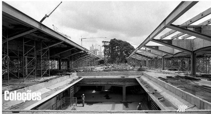
Figura 4 - 3 Estrutura Metálica Pré-Fabricada
